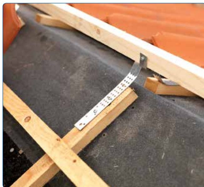
Nockbrädehållare, 25 x 38 läkt för nockpanna
